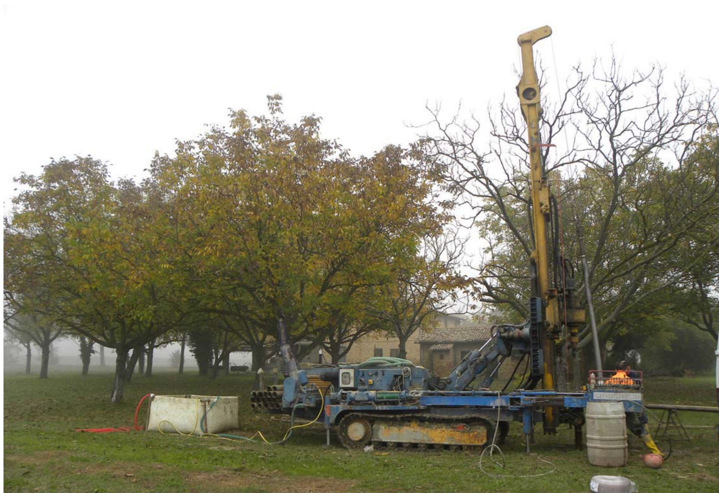
Foto 6: carotaggio continuo presso Via Monte di Pietà (Faenza)
